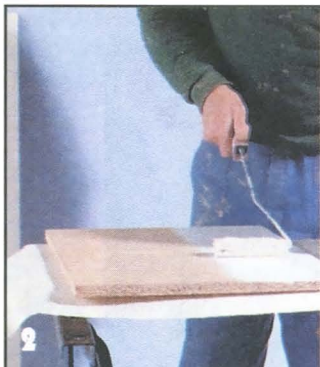
Детали, которые потом обтягивают тканью, необходимо предварительно загрунтовать.
