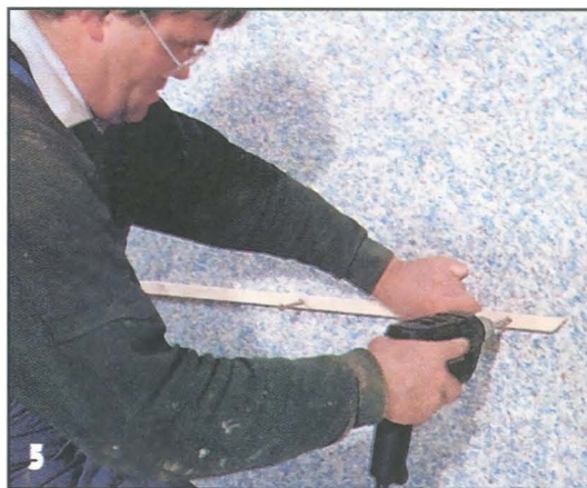
После отделки стены к ней шурупами с дюбелями крепят несущую рейку для вешалки.
